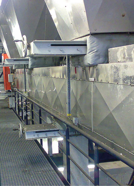
Absperrschieber zwischen E-Filter und Kettenförderer
