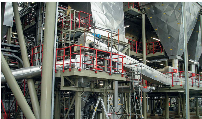
Trogkettenförderer unter E-Filter in einer MVA
